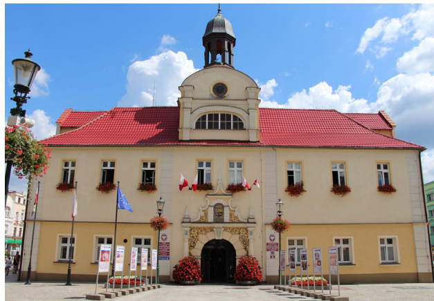
Ratusz w Żarach z zachowanym renesansowym portalem wejściowym.
