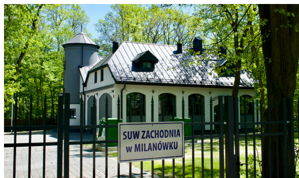
Stacja uzdatniania wody w Milanówku.
