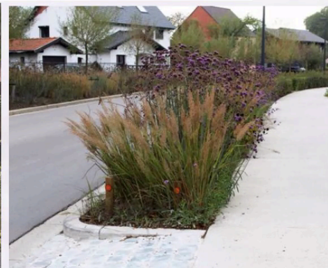
Pasy infiltracyjne zbierające wodę deszczową z ulic i chodników
