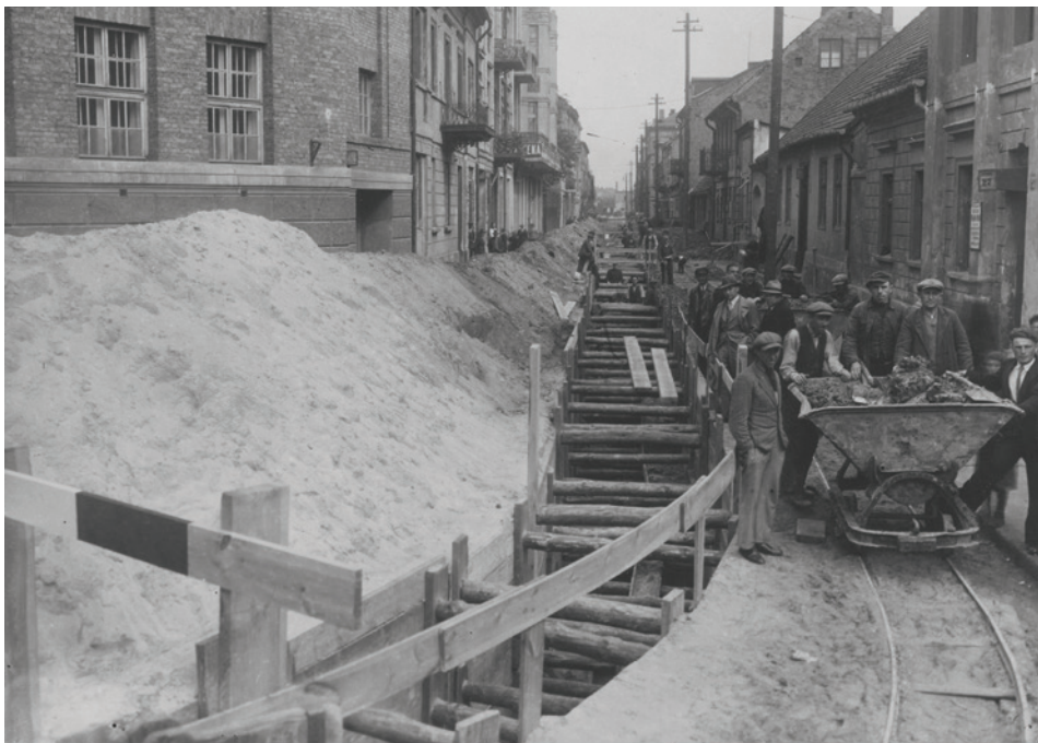
Budowa kolektora kanalizacyjnego na ul. Cyganka we Włocławku. Źródło: NAC
