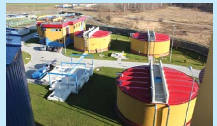
Nowa oczyszczalnia ścieków w Piasecznie.
