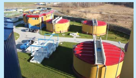
Nowa oczyszczalnia ścieków w Piasecznie.
