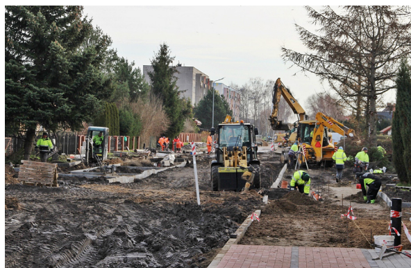
Przebudowa ulicy Bolesława Śmiałego.
