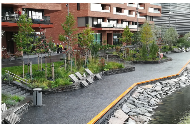
Nowa zabudowa w dzielnicy Biorvika nad fiordem. Obok nowo wybudowanych mieszkań, natychmiast powstają skwery, sadzone są kwiaty i drzewa, instalowana jest mała architektura.
