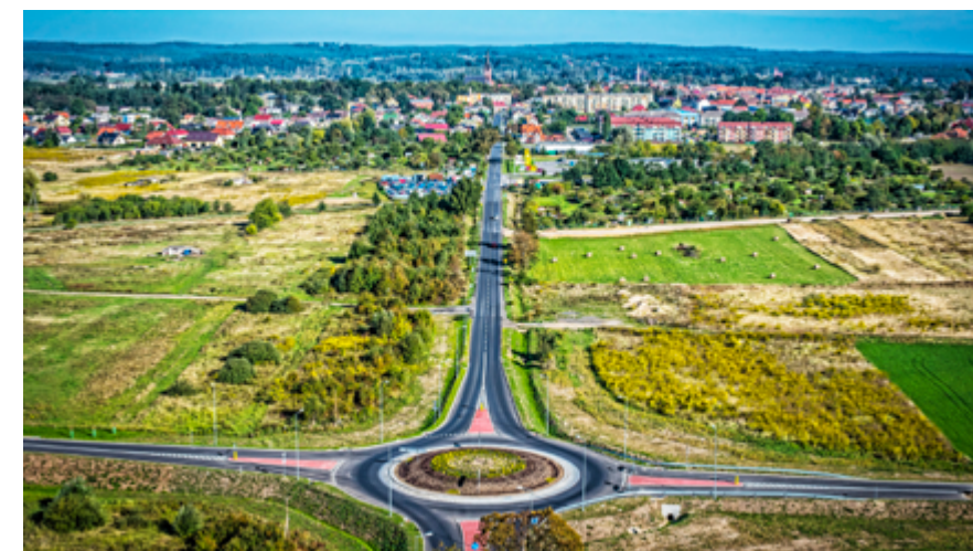
Fragment budowanej obwodnicy Drezdenka.
