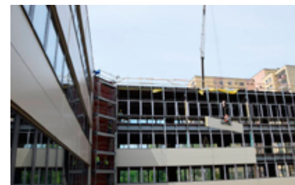
ZSS nr 1 w trakcie termomodernizacji.
