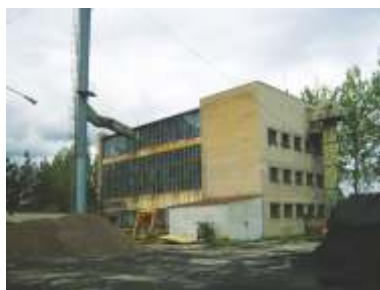
Zdj. 36. Stary budynek ciepłowni do modernizacji (fot. Urząd Miasta Rumi)
