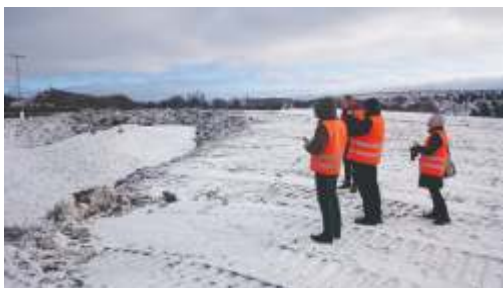
Zdj. 42. Rezerwuar śniegu na potrzeby chłodzenia w okresie letnim na lotnisku w Ullensaker (fot. Andrzej Siwek, Urząd Miasta Lublin)
