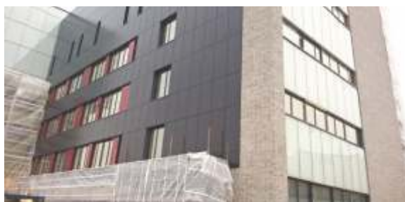
Zdj. 35. Ekologiczna szkoła z fasadą pokrytą ogniwami fotowoltaicznymi, budowana w Oslo (fot. Jerzy Tymczyszyn, Urząd Gminy w Raciechowicach)
