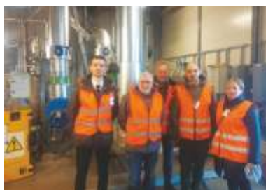
Zdj. 24. System wytwarzania ciepła i chłodu na lotnisku Gardemoen (Oslo) (fot. Sławomir Wraga, Urząd Miasta Lublin)
