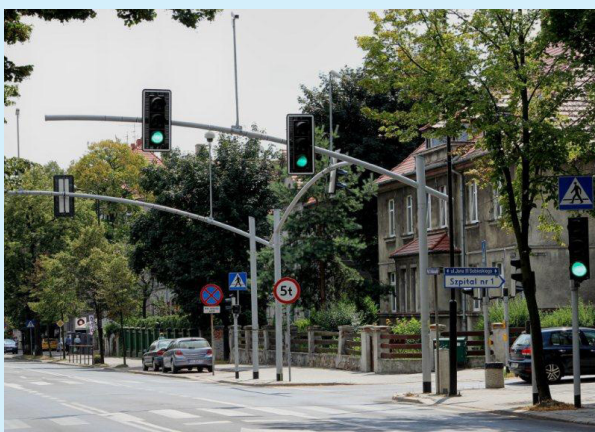
W zmodernizowanych sygnalizacjach świetlnych zastosowano lampy LED po raz pierwszy w Polsce w wszystkich urządzeniach w mieście
