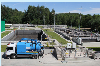
Oczyszczalnia ścieków w Brzezinach oddana właśnie do użytku po modernizacji.
