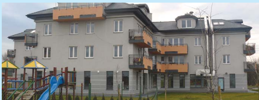
Budynek socjalny w Zamieniu wraz z gminnym przedszkolem.
