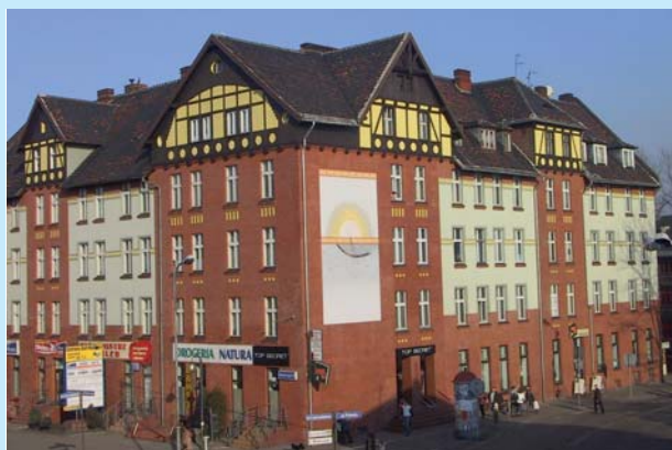
Zabytkowa kamienica w dzielnicy Nowy Bytom.
