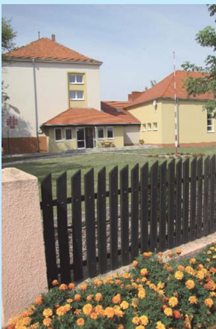
Budynek niepublicznego zespołu szkół w Potarżycy po termomodernizacji dokonanej przez gminę. Tutaj znajduje się jedyne w Polsce (i prawdopodobnie w Europie!) przyszkolne, działające na terenie wiejskim planetarium.
