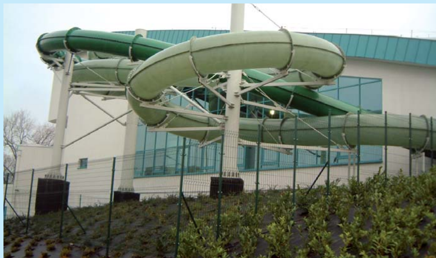
Zewnętrzne atrakcje wodne basenu Centrum Rekreacyjnego w Kołobrzegu. Fot. Arch. UM w Kołobrzegu
