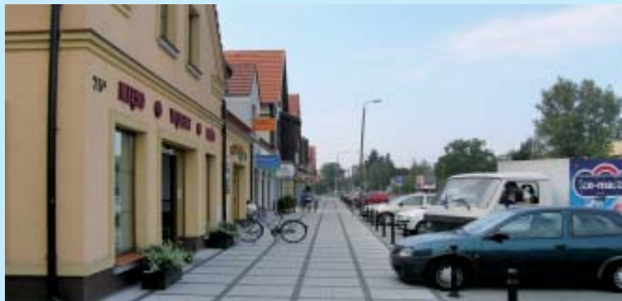
Wyremontowana ulica Poznańska w Puszczykowie i kamieniczki po rewitalizacji. Fot. E. Parchimowicz
