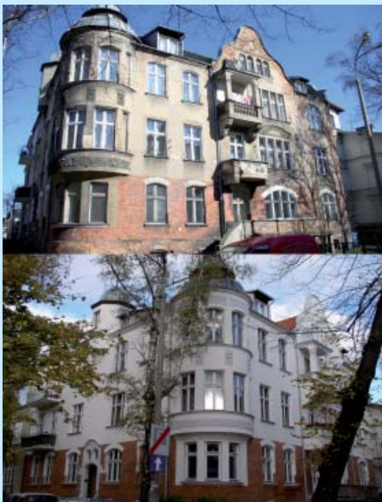
Kamienica przy ul. Chmielewskiego 8 przed i po rewitalizacji.
