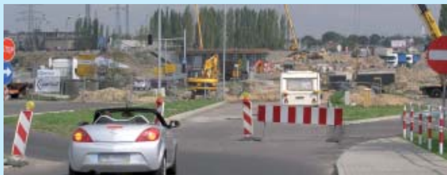
Kolejny etap przebudowy ul. Głogowskiej, drogi wjazdowej do Poznania od strony Wrocławia. Fot. E. Parchimowicz
