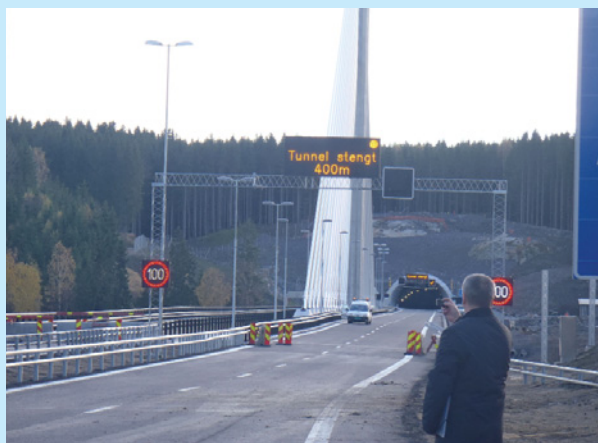
Most wantowy z tunelem w powiecie Ostfold.
