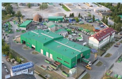
Sortownia odpadów na terenie Miejskiego Zakładu Oczyszczania Sp. z o.o. w Pruszkowie.
