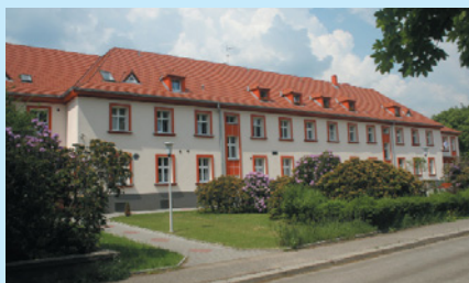
Szpital przy ul. Radiowej w Gliwicach – przed i po remoncie.
