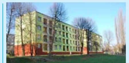
Istotnym efektem prowadzonych działań jest ograniczenie emisji gazów cieplarnianych do atmosfery. Dodatkowy atut to uatrakcyjnienie obiektu dzięki odnowieniu elewacji budynków, co wpływa korzystnie na wizerunek miasta oraz samych osiedli.
