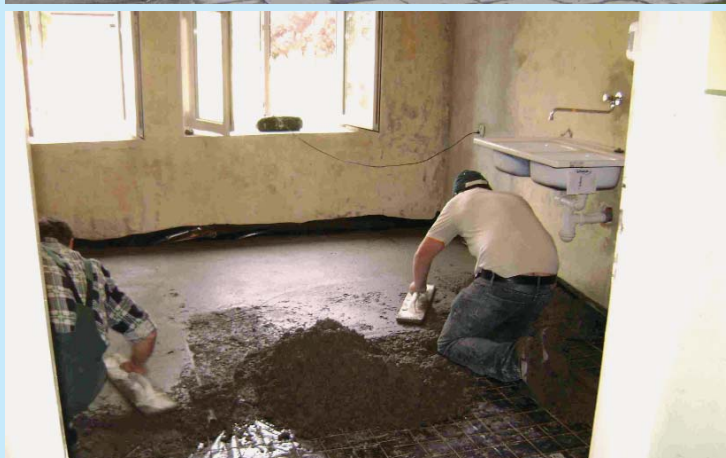
Bezrobotni z budynku przy ulicy Leszczyńskiej w trakcie prac remontowych. Fot. Archiwum MOPS w Oświęcimiu
