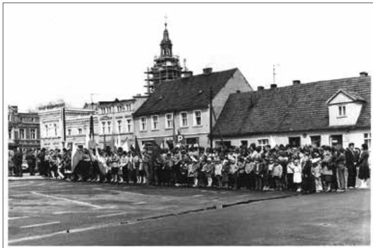
13. Rynek w Krobi, w tle rozbiórka rusztowania odbudowanej wieży (1982 r.)
