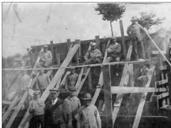
108. Budowa mostu przy ul. Poznańskiej w Krobi w 1936 r. (zdjęcie już bardzo zniszczone, ale o unikalnej wartości)
