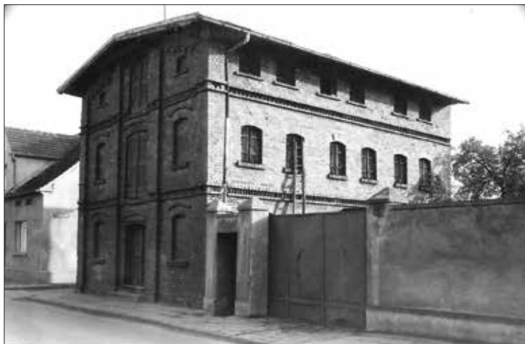
41. Stajnia dla koni pocztowych przy ul. Kobylińskiej w Krobi
